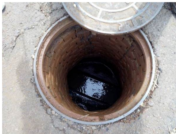
Figura 2: Constatação da normalidade de fluxo de esgoto em Poço de Visita
