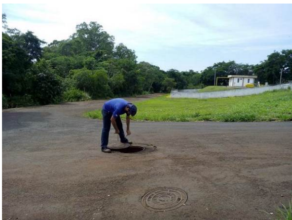
Figura 1: Verificação VDE em Poço de Visita
